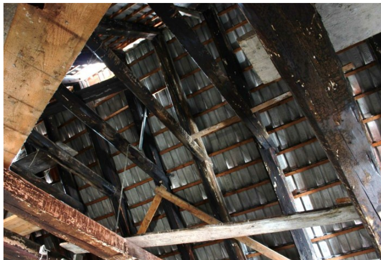
© (S. Lipinski) Historischer Dachstuhl
