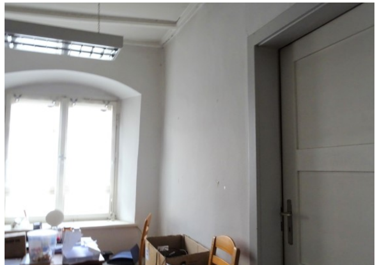
© (D. S. - B.) Zimmer mit historischem Fenster
