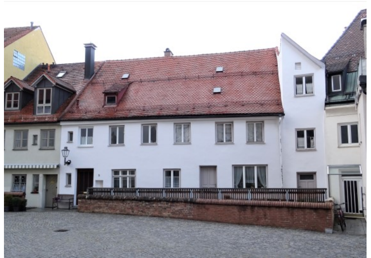
© (D. S. - B.) Rückseite des ehem. Handwerkerhauses
