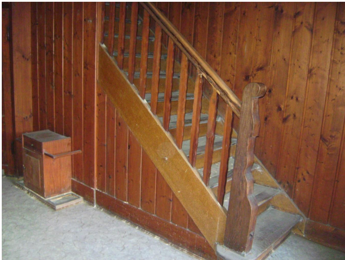
© (J. Rädler) Flur im EG mit Treppe zum 1.OG
