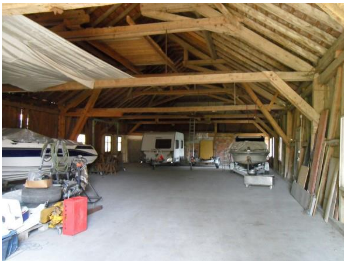
© (F. Rädler) Beachtlicher Nutzraum mit Betonboden im OG des Wirtschaftsgebäudeteiles
