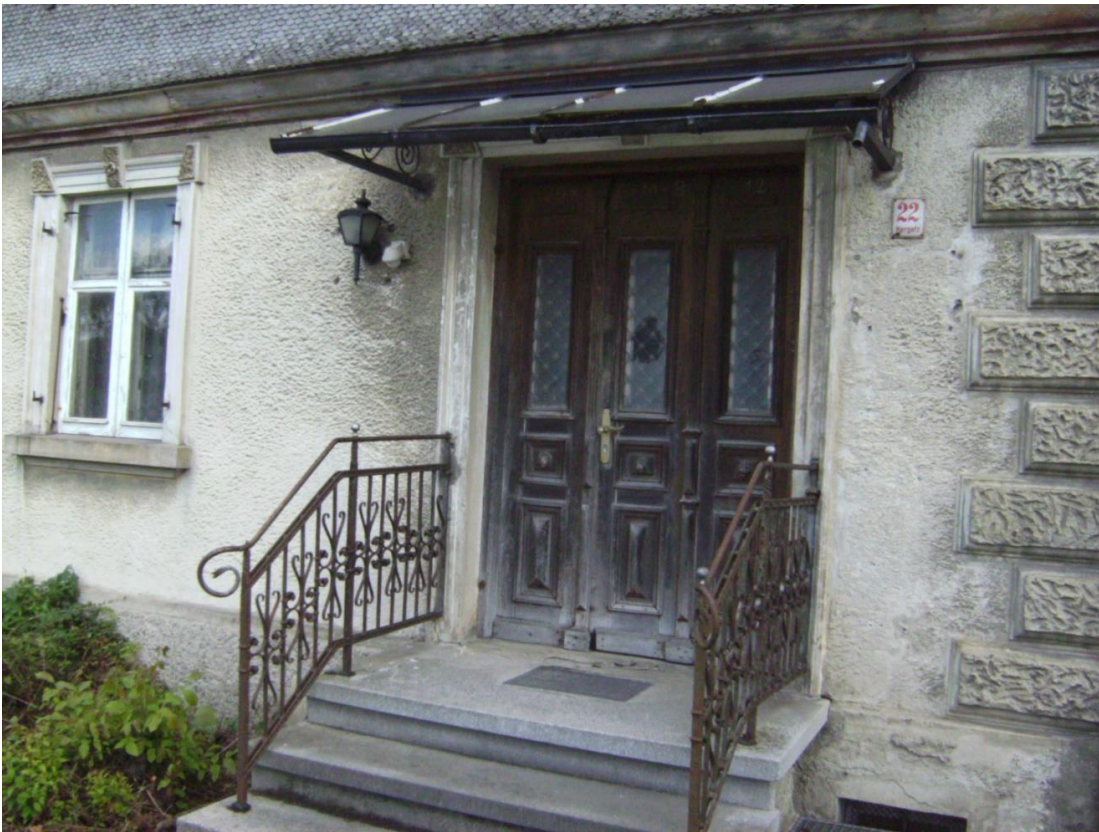
© (J. Rädler) Nordseitiger Hauseingang mit historischen Details
