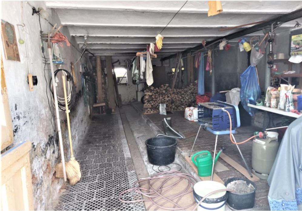
© (J. Schaumann) Großer Stall mit Gewölbedecke
