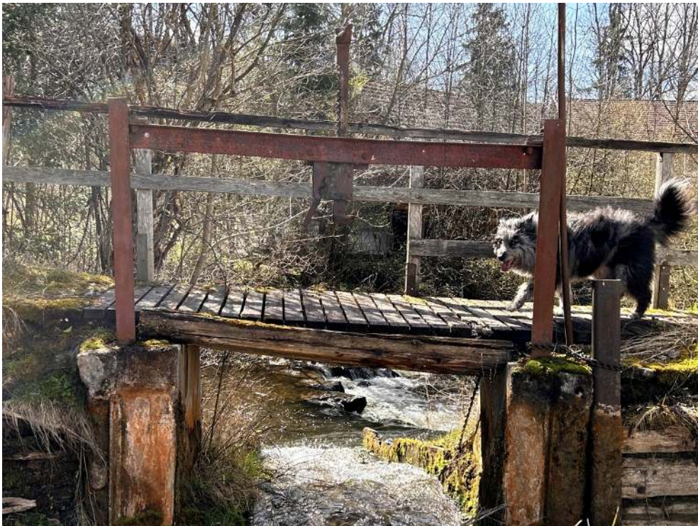
Wehr am Oberwasser
