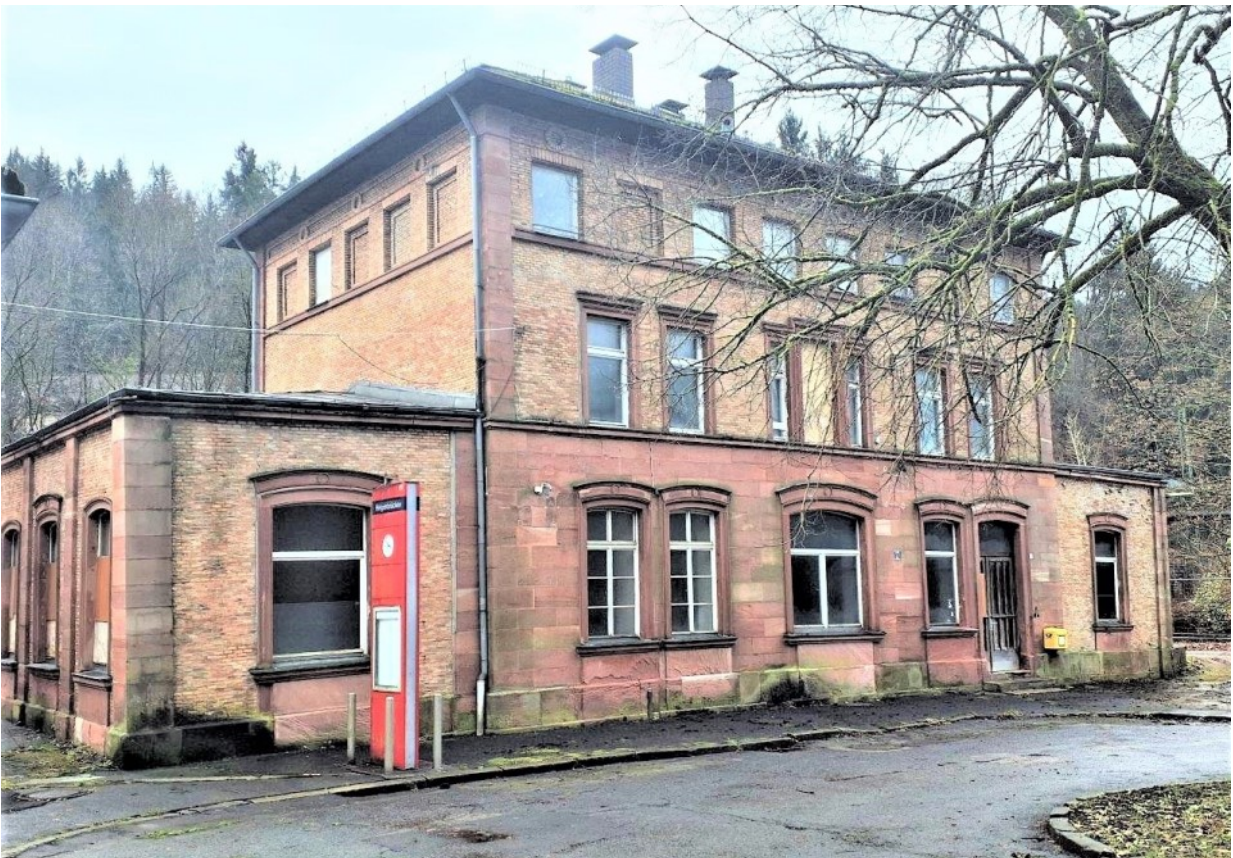
© (Gde. Heigenbrücken) Historischer Massivbau aus Rotsandstein (EG des Mittelbaus) und Ziegelbauweise
