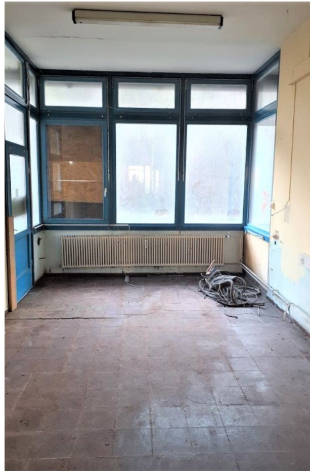
© (Gde. Heigenbrücken) Ehem. Bereich des Fahrdienstleiters
