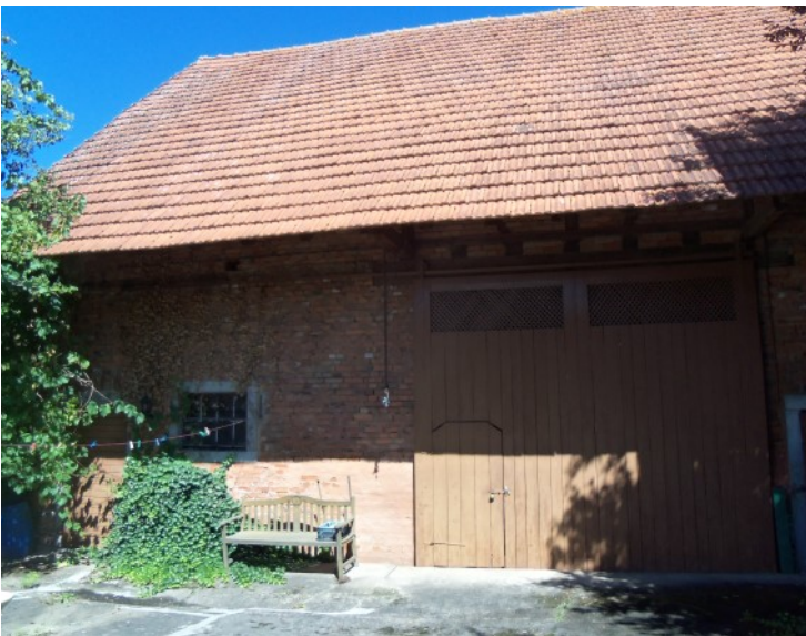
© (O. Glaab) Stattliche Scheune mit Stall
