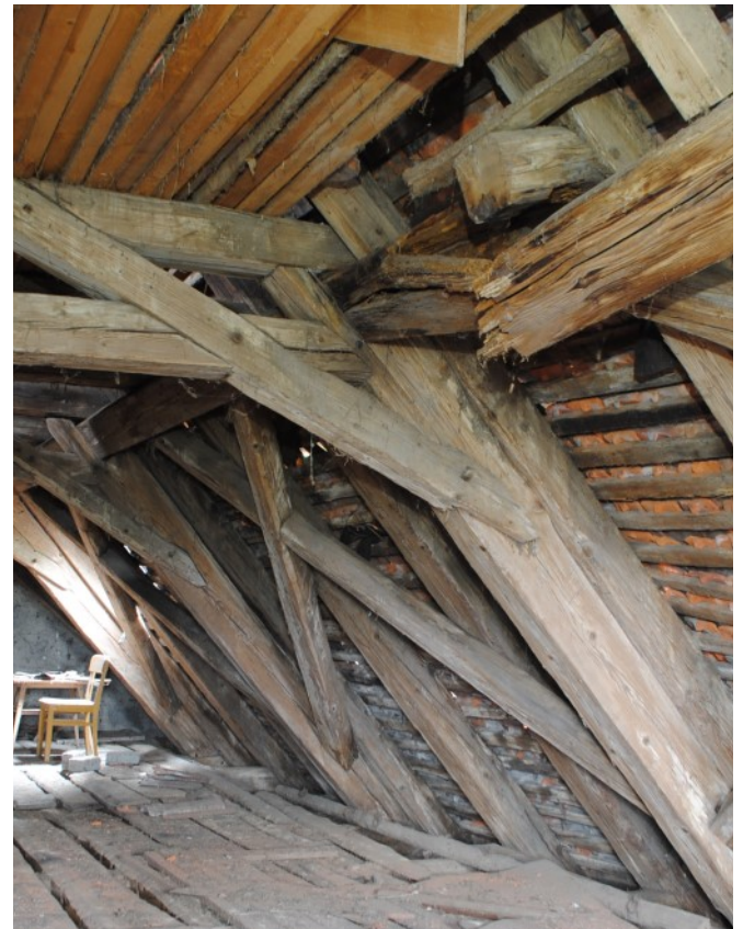
© (K. Schnieringer) Dachbereich mit Geschichte
