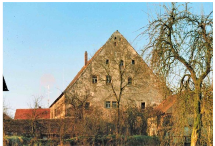
© (R. Wagner) Ehemaliges Wasserschloss
