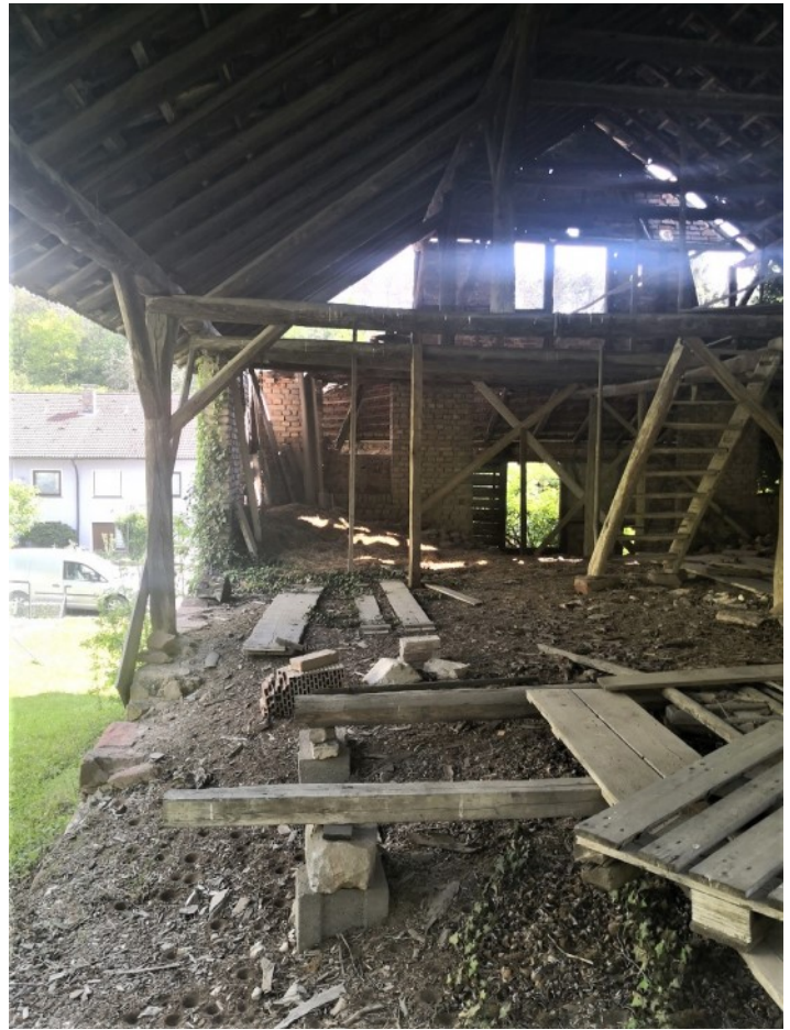
© (D. Ladurner) Innenansicht des ehemaligen Fabrikationsgebäudes
