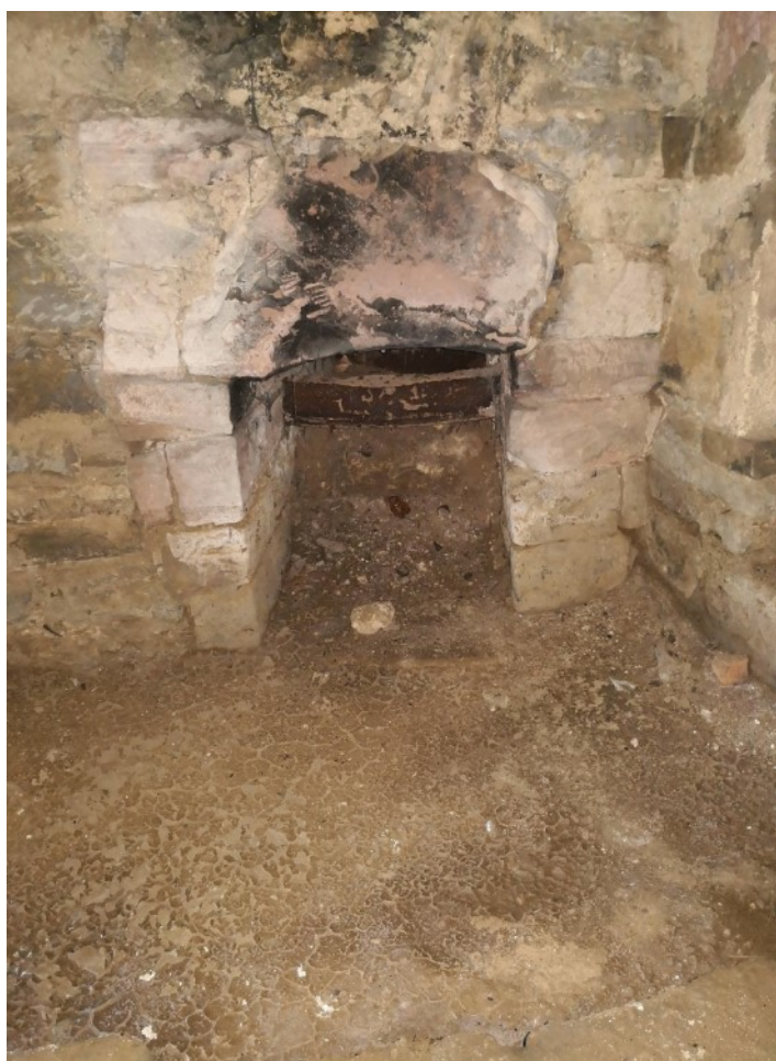
© (D. Ladurner) Ausgang des aktiven Schachtes
