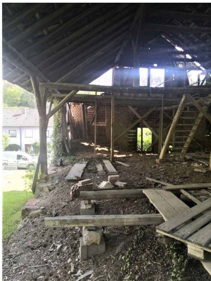
© (E. d. A.) Innenansicht des ehemaligen Fabrikationsgebäudes
