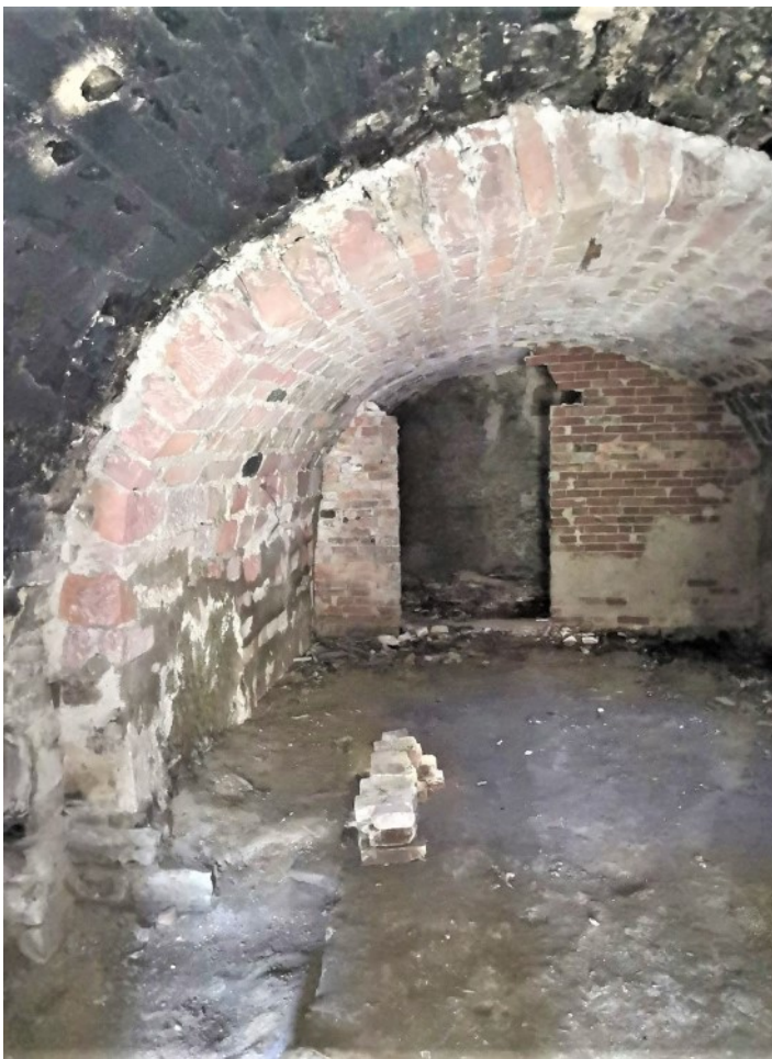
© (E. d. A.) Großer Gewölbekeller
