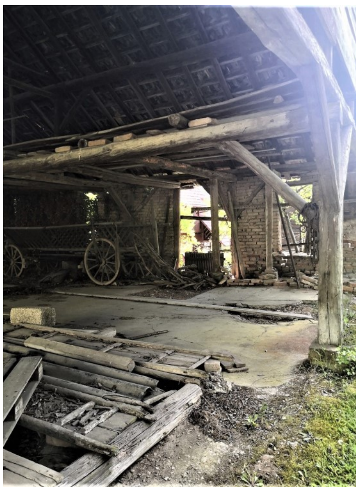
© (E. d. A.) Ehemaliger Fertigungsbereich
