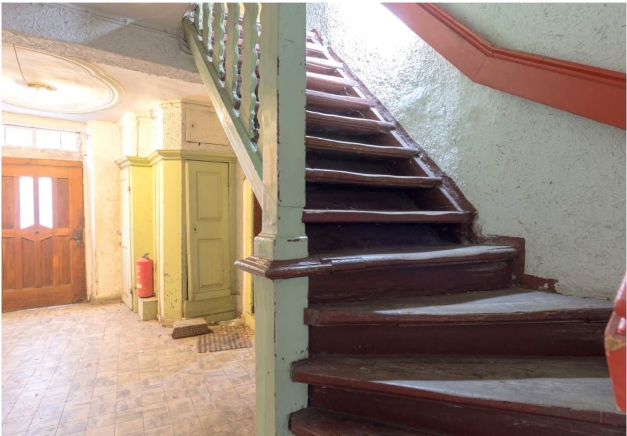
© (E. d. A.) Treppenaufgang ins OG
