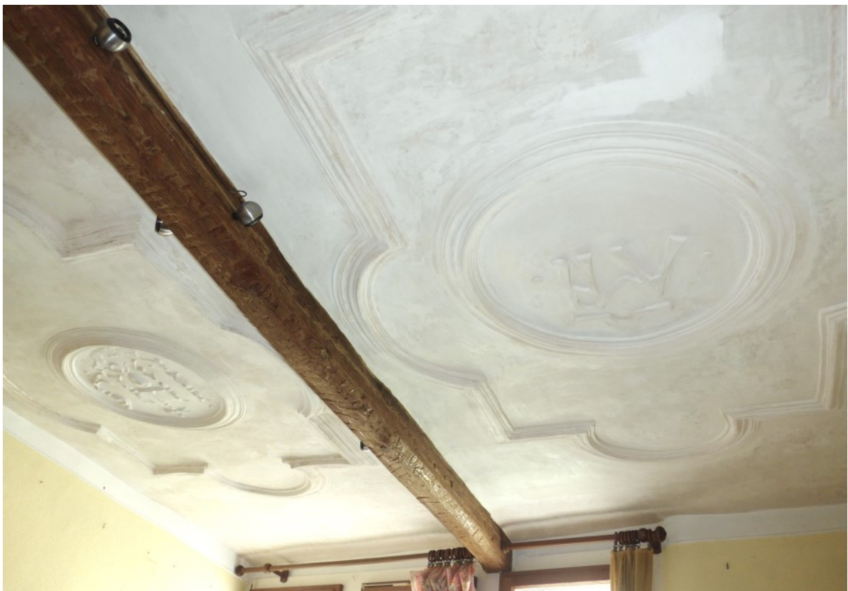
© (BLfD) Malerische Stuckdecke im OG
