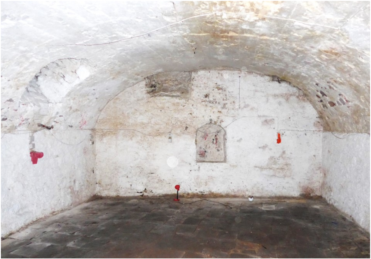
© (BLfD) Historischer Gewölbekeller
