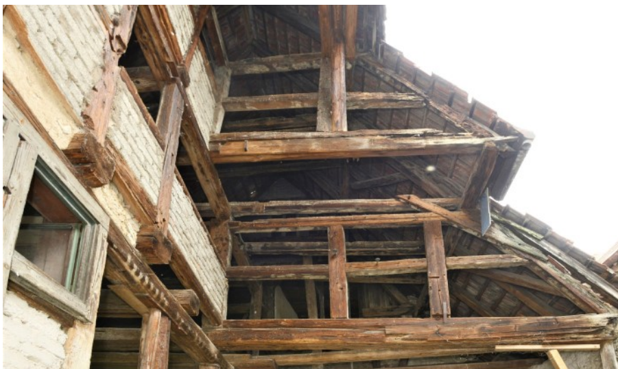
© (G. Gronauer) Dreigeschossige Trockenlaube im rückwärtigen Bereich
