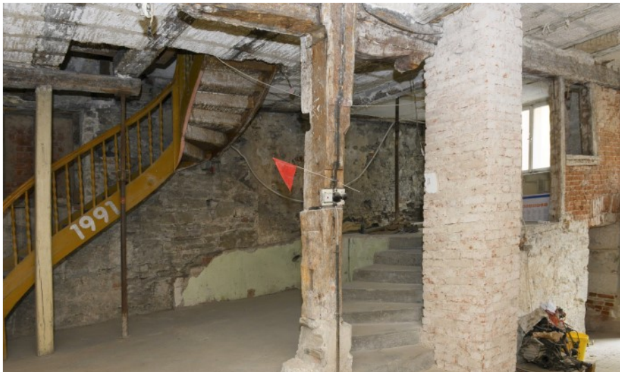
© (G. Gronauer) Treppenaufgang ins OG
