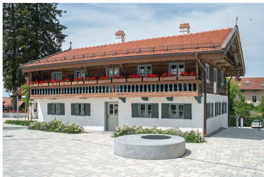
Maitenbeth, Lkr. Mühldorf am Inn, Alte Post von Süden nach der Instandsetzung (Foto: BLfD, Michael Forstner)
