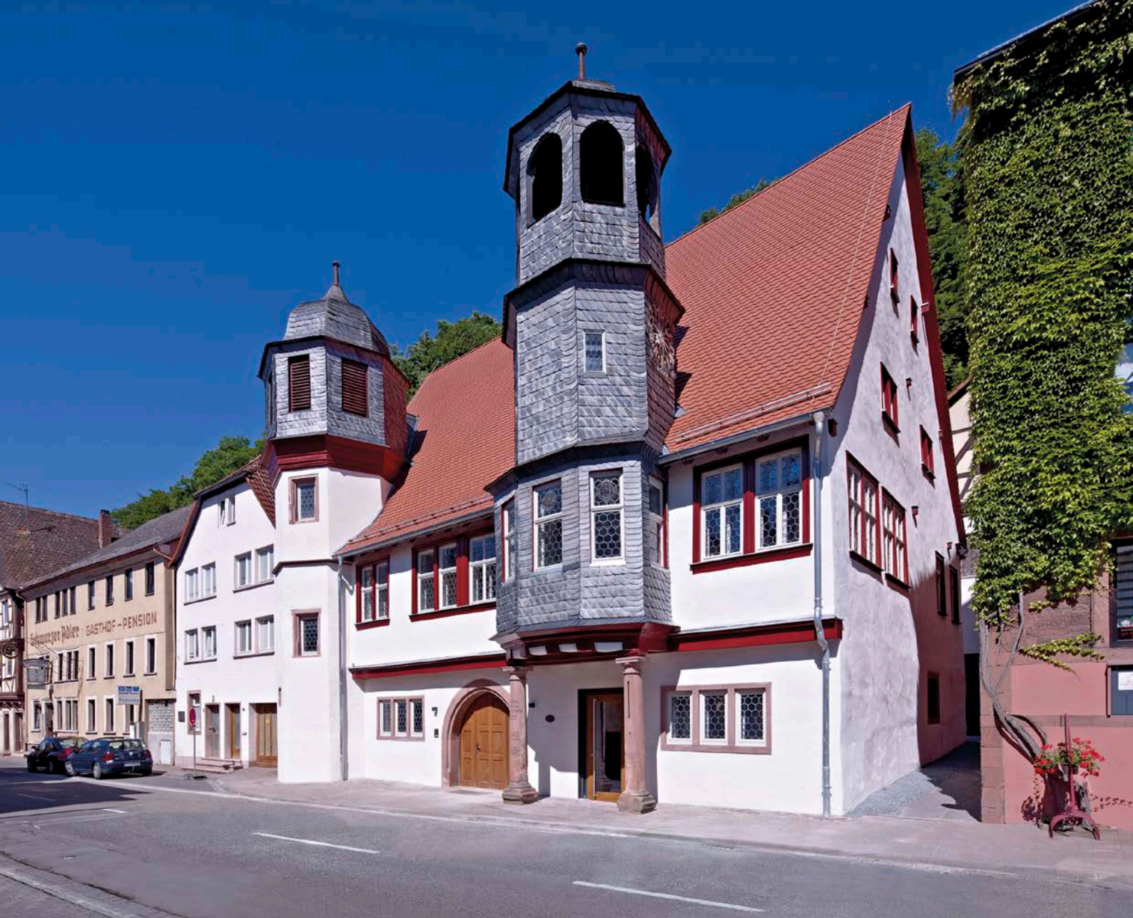
Stadtprozelten, Lkr. Miltenberg, Rathaus, Nord-West-Ansicht nach der Instandsetzung (Foto: Studio Tschöp, Wertheim)
