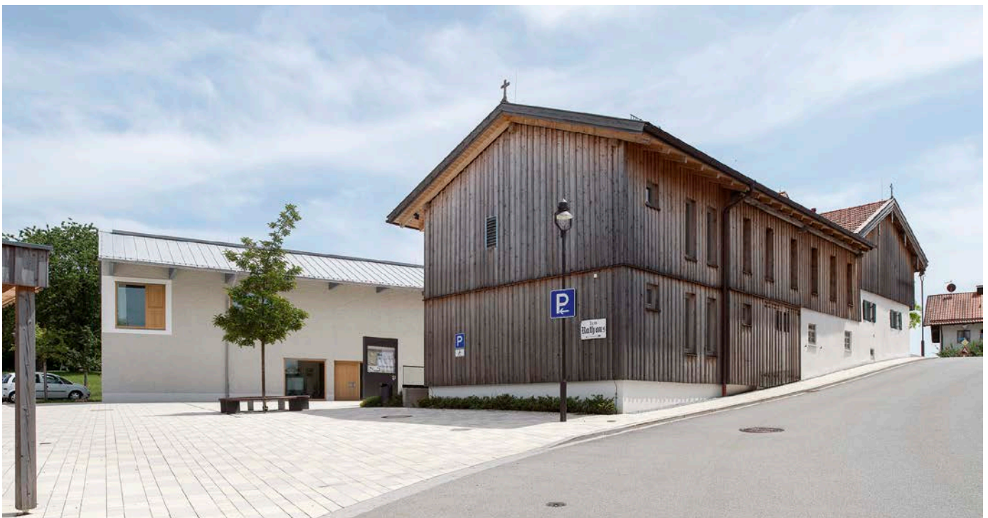
Maitenbeth, Lkr. Mühldorf am Inn, Alte Post mit Anbau und neuem Rathaus, von Nordwesten (Foto: BLfD, Michael Forstner)
