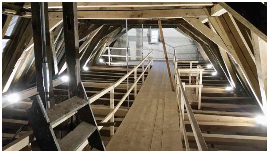
Stadtprozelten, Lkr. Miltenberg, Rathaus, das Dachwerk wurde zimmermannsmäßig repariert und durch ein Hängesprengwerk ertüchtigt (Foto: BLfD, Martin Brandl)
