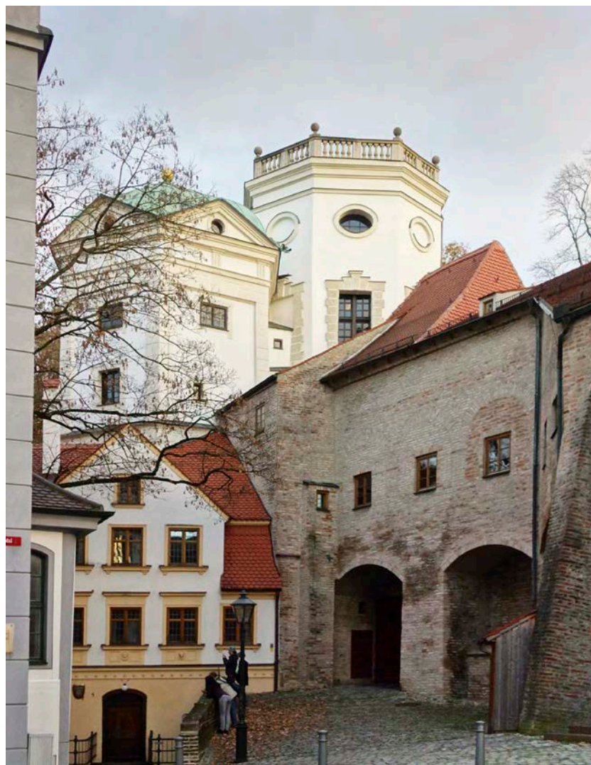
Augsburg, Wasserwerk am Roten Tor, mit Großem Wasserturm (nach 1463, Erhöhung und Veränderung 1669 und 1746), Kleinem Wasserturm (14670, Veränderungen 1556/59 und 1746) und Kastenturm (im Bild nicht sichtbar – spätmittelalterlich, Veränderungen 1599 und 1703) (Abb. aus: Nominierungsdossier Stadt Augsburg, S. 50)
