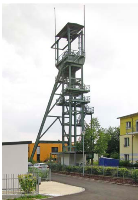
Sulzbach-Rosenberg, Förderturm St. Anna nach der Stilllegung, 2014 (Foto: BLfD, Christian Dümmler)
