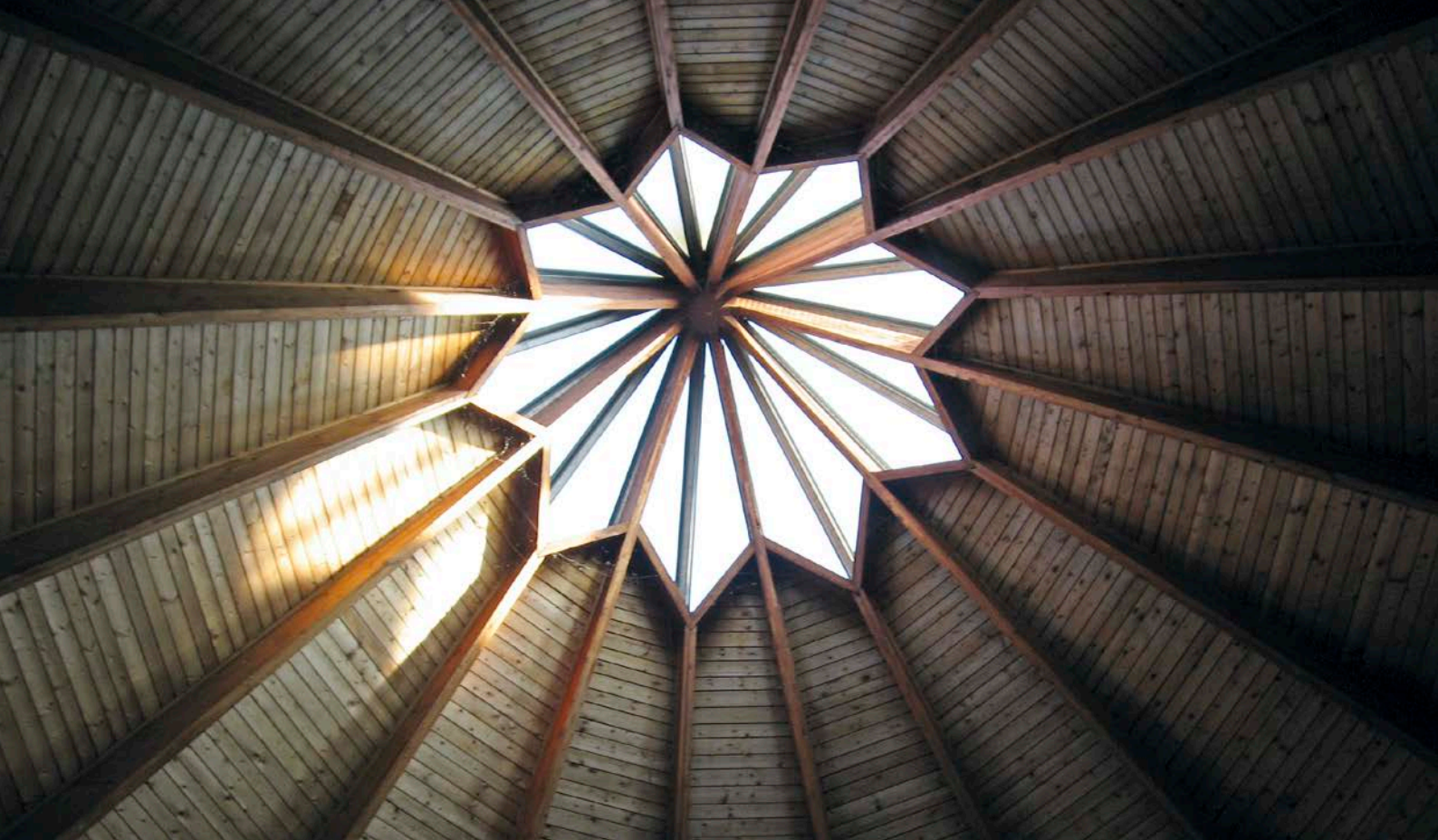
Kelheim, Lukaskirche, Blick in die Sparrenkonstruktion des Kegdachs
