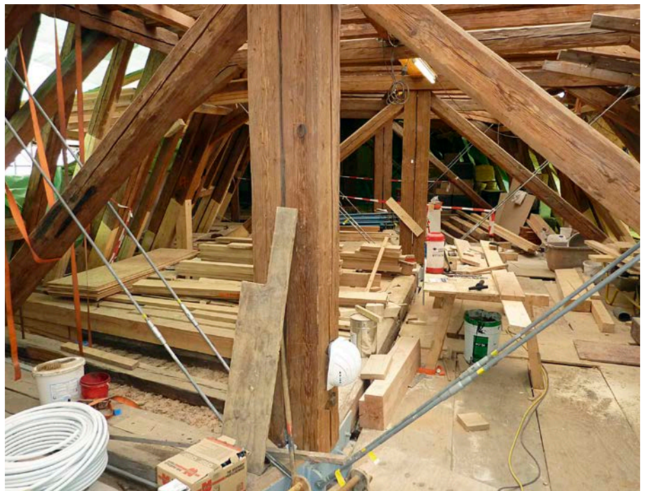
Erlangen, Orangerie, Instandsetzung des Dachtragwerks (Foto: Staatliches Bauamt Erlangen-Nürnberg, Hannes Csernetzky)
