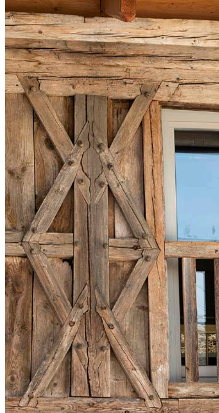
Maitenbeth, Lkr. Mühldorf am Inn, Alte Post, Detail der Ostfassade nach Instandsetzung (Foto: BLfD, Michael Forstner)
