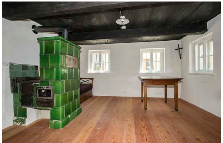
Maitenbeth, Lkr. Mühldorf am Inn, Alte Post, oben Postfiliale mit weitgehend erhaltener Ausstattung, darunter Stube im Erdgeschoss, nach der Restaurierung (Fotos: BLfD, Michael Forstner)
