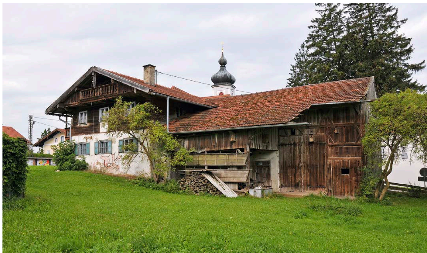
Maitenbeth, Lkr. Mühldorf am Inn, Alte Post von Osten, Vorzustand (Foto: Gemeinde Maitenbeth)
