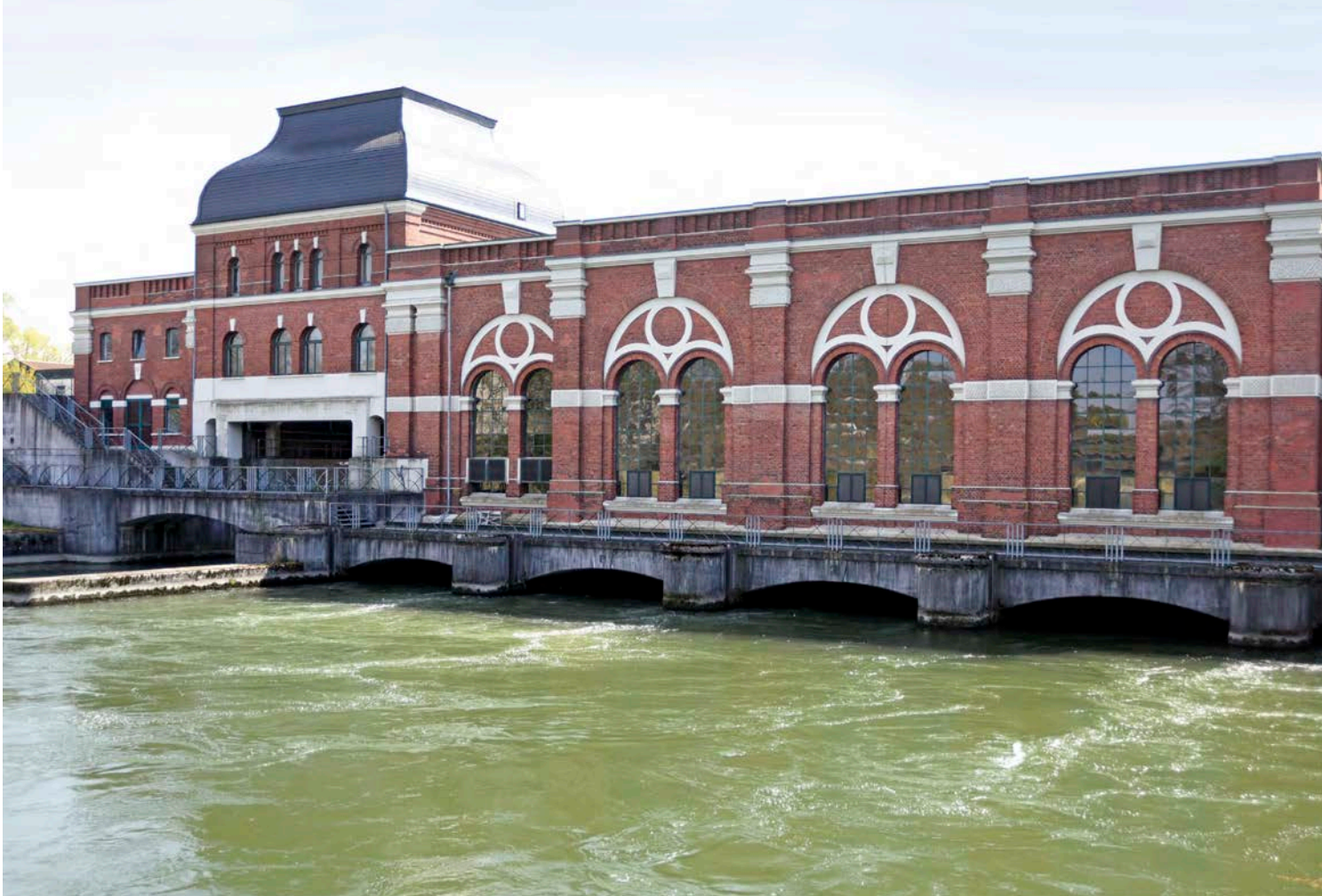
Wasserkraftwerk am Lechkanal in Gersthofen, 1900/01 (Abb. aus: Nominierungsdossier Stadt Augsburg, S. 122/123)
