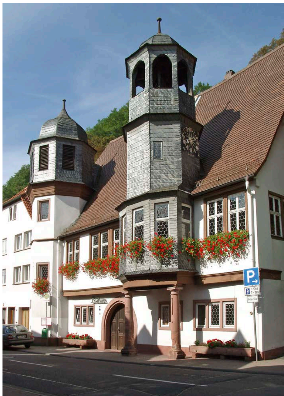
Stadtprozelten, Lkr. Miltenberg, Rathaus, Nord-West-Ansicht, Vorzustand (Foto: Büro Neu, Darmstadt)
