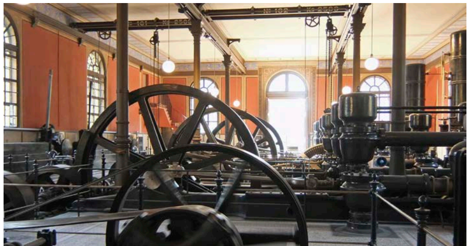
Augsburg, Wasserwerk am Hochablass, 1878/79, Maschinensaal (Abb. aus: Nominierungsdossier Stadt Augsburg, S. 66/67)
