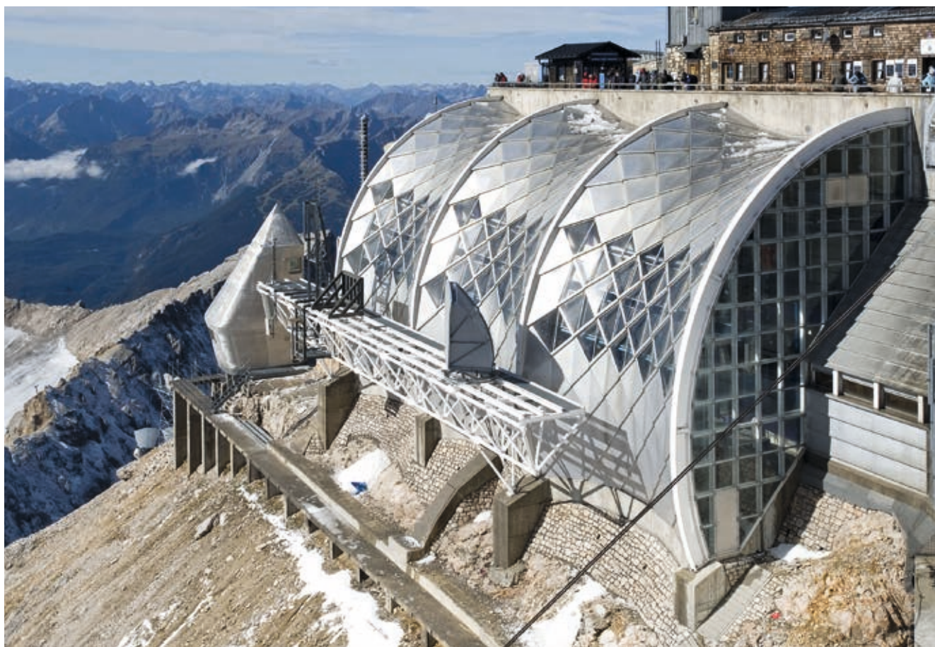
Zugspitze, Richtfunkstation mit südlichem Antennenträger, im Hintergrund: Messtation für Höhenstrahlung (Foto: BLfD, Michael Forstner); oben: nördlicher Antennenträger der Richtfunkstation (Foto: BLfD, Detlef Knipping)
