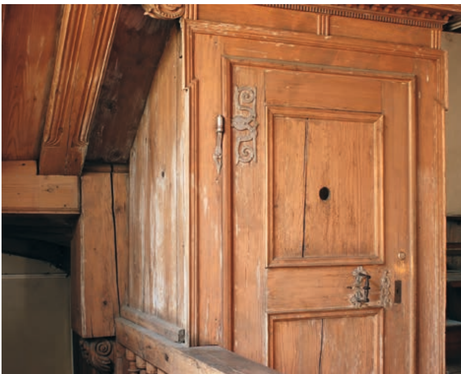
Nicht immer sind Biozide visuell erkennbar wie im Fall dieser Ausstattung – hier deuten kristalline Ausblühungen auf eine Kontamination durch Holzschutzmittel hin (Foto: BLfD)
