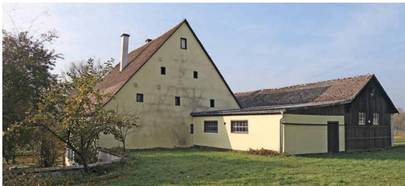
Seitenmühle, Ansicht von Nordosten (Foto: BLfD, Almut Schöffner-Knoblach)
