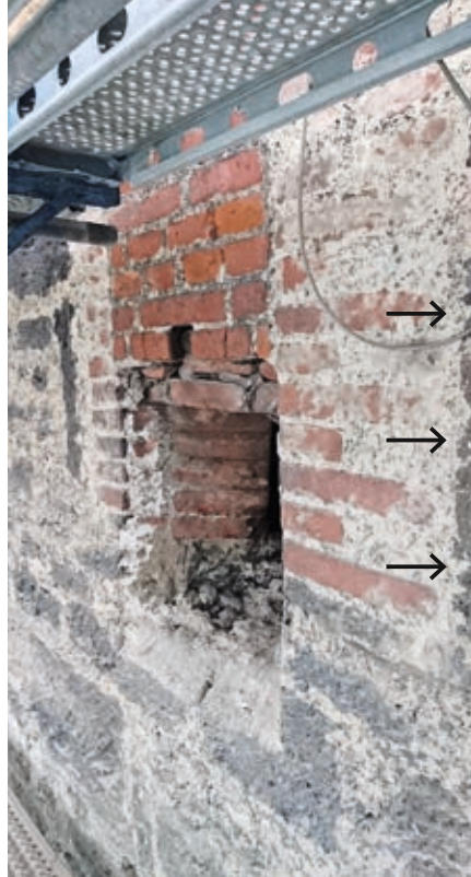
Schießscharte, Feldseite mit gut erkennbaren Spuren der unterschiedlichen Umbauphasen; rechts am Bildrand (Pfeile) die Schlitzscharte der ersten Bauphase (Foto: Ludwig Kögl)
