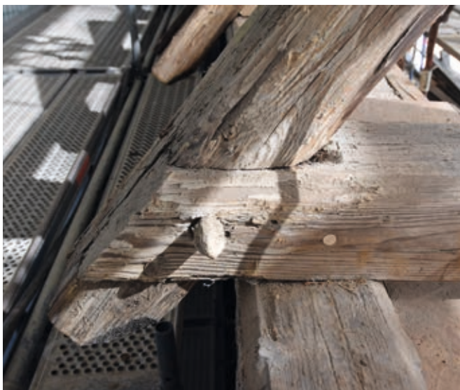
Links: Typisches Fußpunktdetail der Bindergespärre mit geblattetem Fußpunkt und arretierendem Holznagel zwischen Zerrbalken und Schwelle
