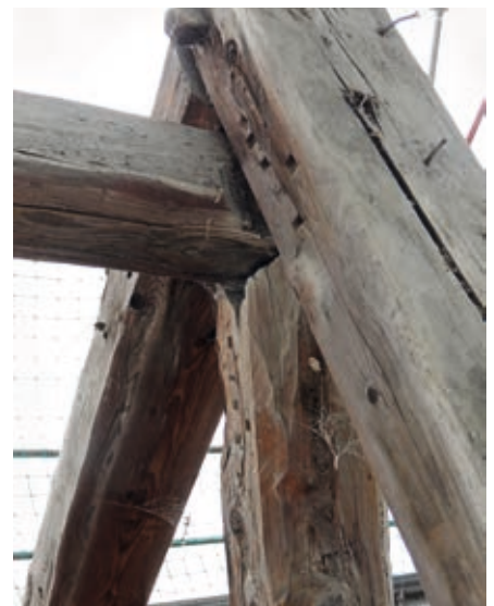
Rechts: Typisches Firstpunktdetail mit Abbundzeichen des ausgehenden 14. Jahrhunderts (Fotos: Christian Kayser)
