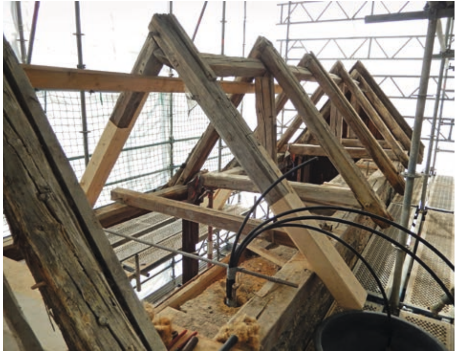
Instandsetzungsarbeiten an Wehrgangüberdachung und Mauerwerk: zimmermannsmäßige Reparaturen an der Holzkonstruktion und Probebohrungen für die Vertikalverankerung der Brustwehr (Foto: Victoria Schuster)
