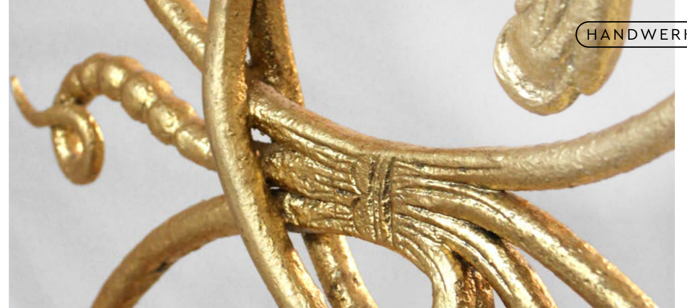
Detail eines Gitters im Freisinger Dom (Foto: Jörg Euteneuer)
