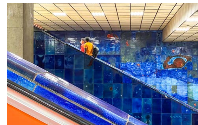
Oben: Rolltreppenaufgang am Scheidplatz Deutlich erkennbar sind hier bräunliche Grundtöne einer anderen Brenncharge, die aber dennoch verwendet wurde. Unten: In dieser Ecke des Sperrgeschosses wurden sogar Reste und Abschnitte der wertvollen Fliesen verbaut. (Fotos: BLfD, Judith Schekulin)
