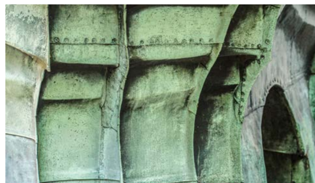
Stiftskirche Aldersbach, historische Bleche, Falze und Nietverbindung, 1755 (Foto: Wolfgang Huber)
