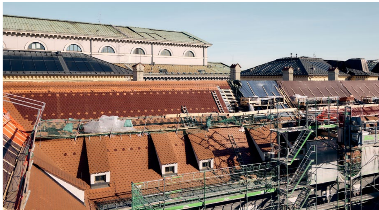
Indachanlage der Alten Münze während des Baus im November 2025 (Foto: Nicolaj Koraus)
