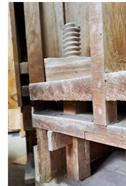
Details der Schraubverbindungen auf der Rückseite des Hochaltars (Fotos: Julian Schmid)
