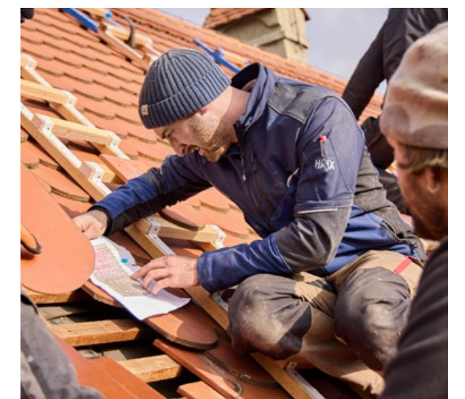
Elektrofachplaner beim Prüfen des Stringplans (Foto: Nicolaj Koraus)
