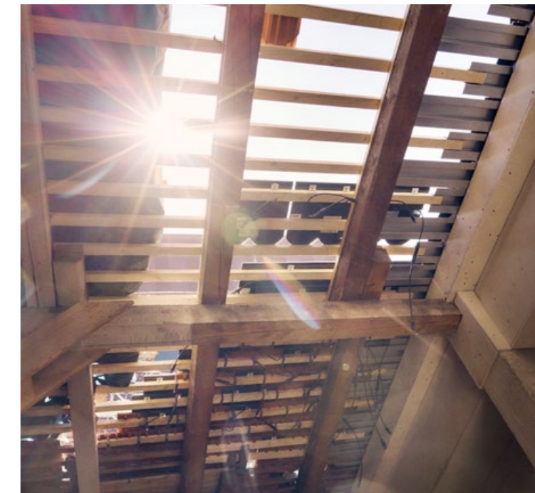
Blick unter die Dachhaut beim Verlegen der Musterfläche (Foto: Nicolaj Koraus)
