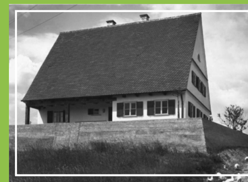
Fotografie des Gebäudes von Süden, Datum unbekannt (Foto: Dominikus Böhm-Archiv, Deutsches Architekturmuseum, Frankfurt am Main)
