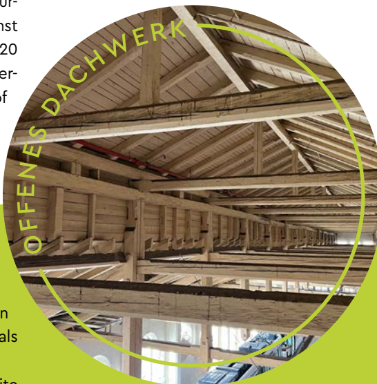
Blick in den Bereich der Laterne, ehemals mit Abzugsöffnungen für Rauch und Dampf. (Foto: Christian Kayser)
