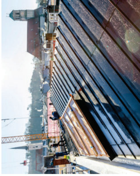
Oben und unten: Spenglerarbeiten und Montage am Solardach (Fotos: Burkhardt Djermeister)
